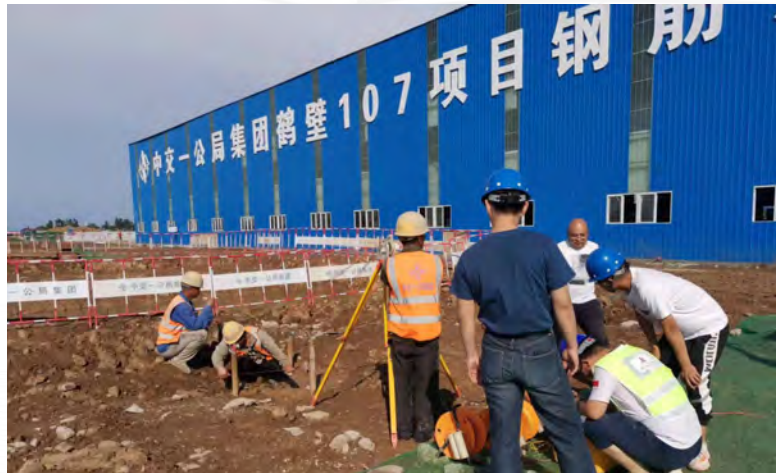
国道107京港线鹤壁境改线新建工程监理桩基完整性检测抽检
