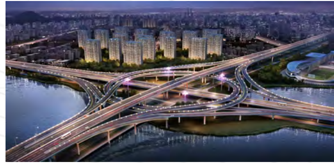
信阳市北环路快速化改造工程
