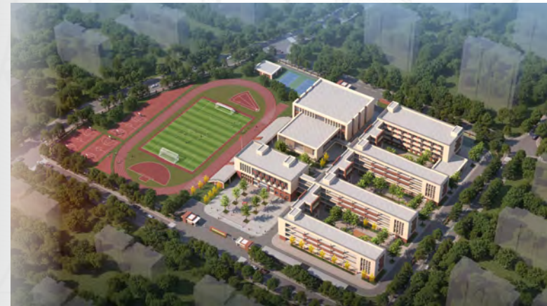
全过程咨询——宿州市萧县梅山学校建设工程
