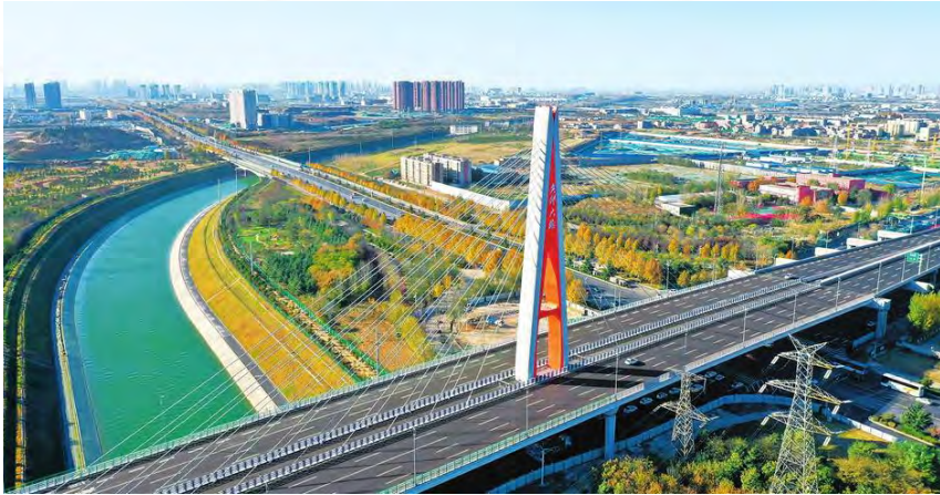
郑州市四环快速化工程
