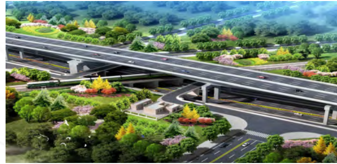
郑州市农业路(西四环-西三环)快速化工程
