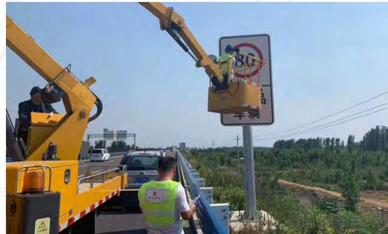
安罗高速公路中牟至周口段维修保养施工监理护栏厚度检测抽检
