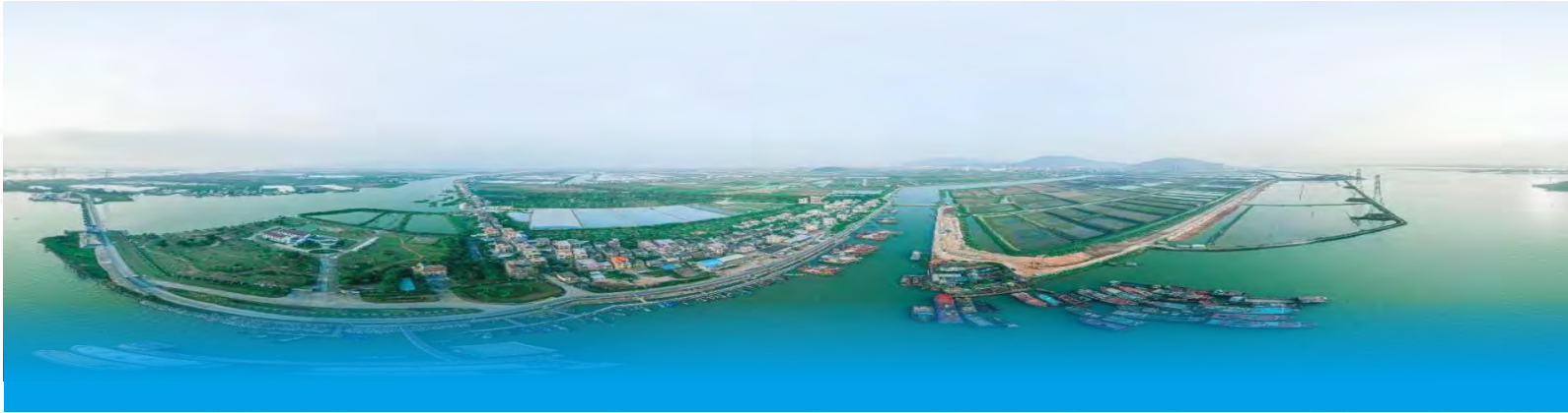
中珠联围海堤(马角至大涌口水闸段)加固工程
