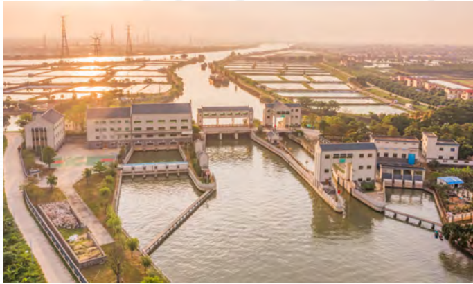
广东中山市阜沙镇鸦雀尾水利枢纽工程
